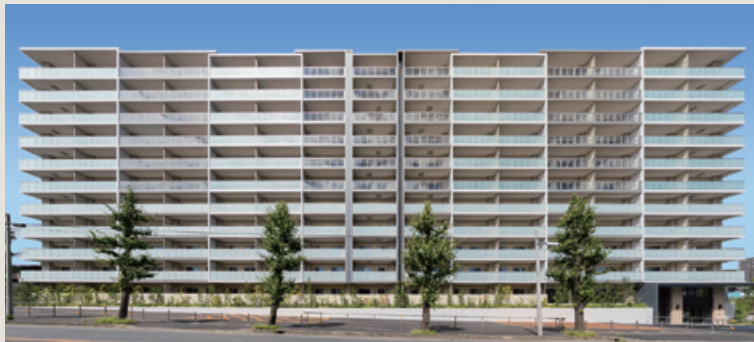
■ 神奈川県藤沢市円行計画新築工事（神奈川県）
