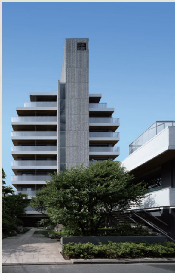
■ シャトレ信濃町リファイニング工事（東京都）
