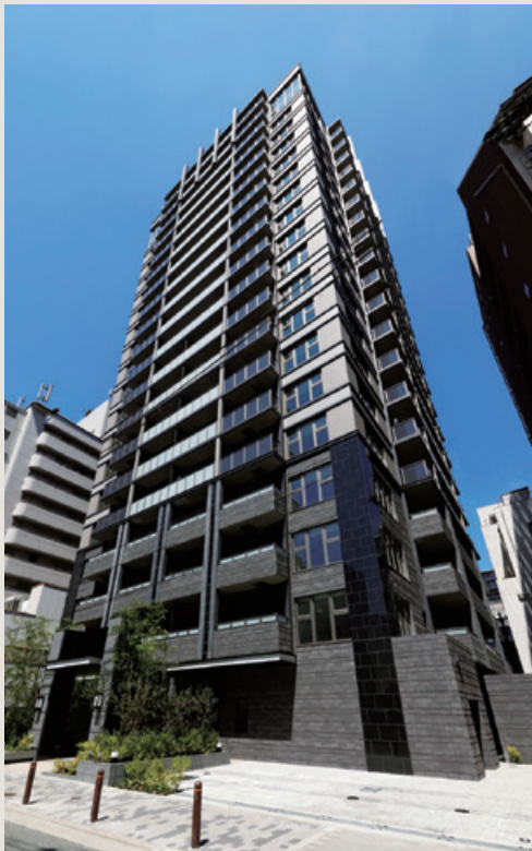
■ プレサンスロジェ新町タワー新築工事（大阪府）
