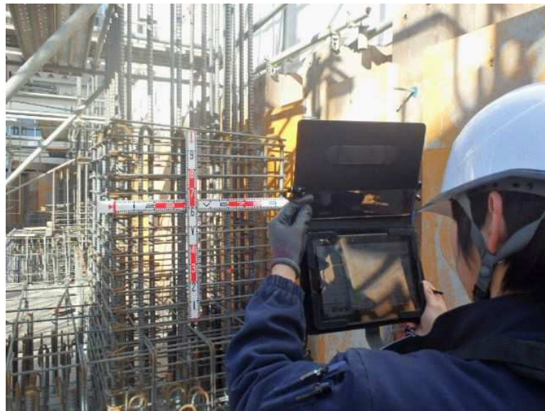
(写真 1, 配筋写真撮影状況)
